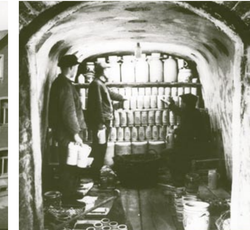
Abb. 14 Mit dem hier abgebildeten Kannenofer der Eulerei konnte Emil SAHM die Bierkrüge erstmals in Eigenproduktion herstellen.
